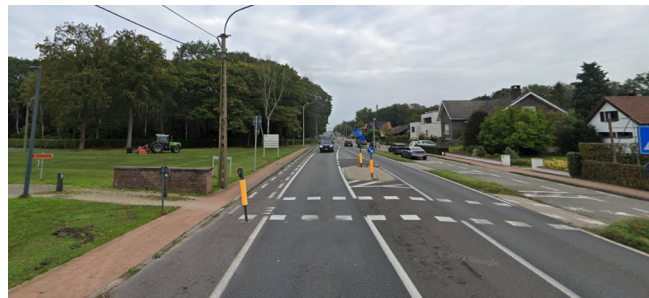
Bestaande fietsoversteek BFF over de N370
