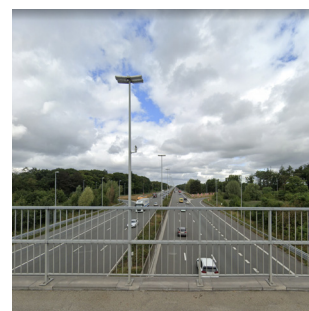
Bestaande brug over de E40
